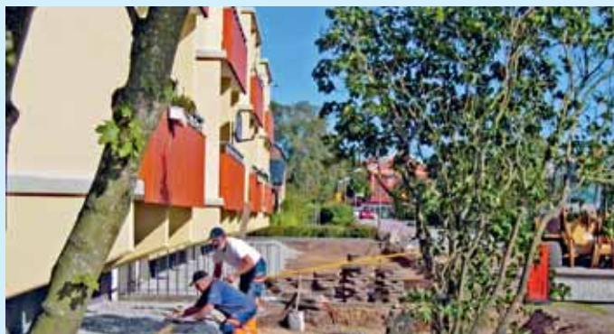
Här pågår utomhusarbeten vid Mjällby 13:70, Kyrkvägen 7 i Mjällby
